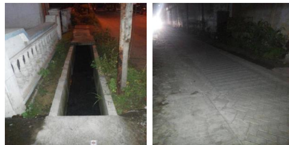
Gambar 2. Pembangunan Saluran Air dan Jalan di Desa Tegalondo
